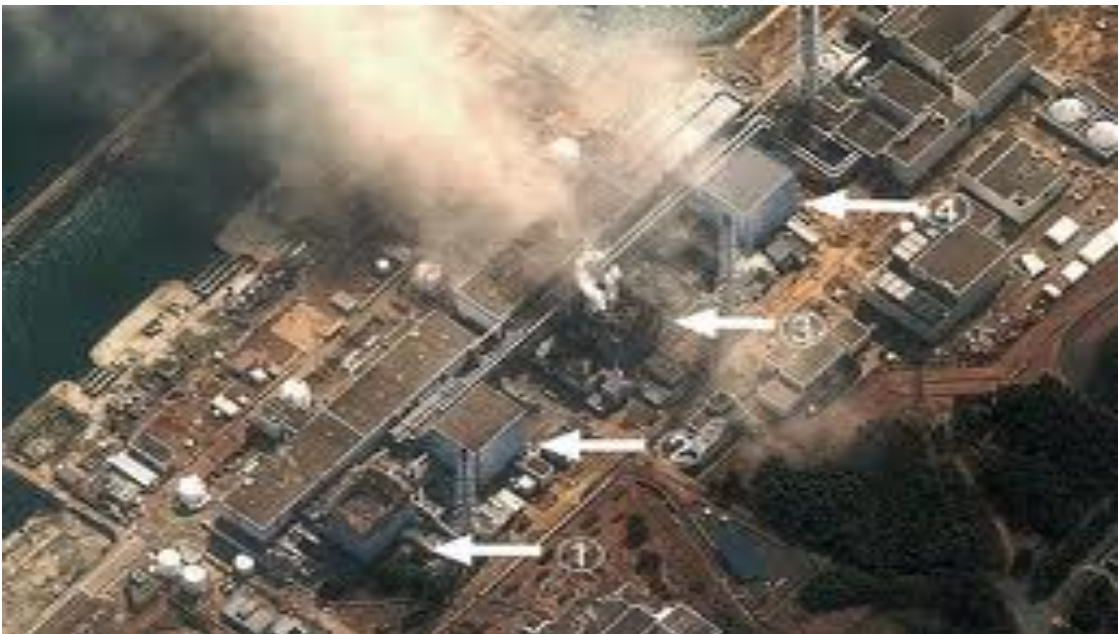
米シンクタンク、科学国際安全保障研究所（I S I S）が公表した、14日に撮影された福島第一原発の衛星写真。（矢印下から順に）12日の爆発で建屋が損傷した1号機、15日に爆発が確認された2号機、14日の爆発で建屋が損傷した3号機。上は4号機（デジタルグローブ・I S I S提供・共同）
