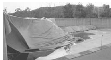
高濃度の放射性物質が検出された熔融スラグのストックヤード＝郡山市日和田町・県中浄化センター
