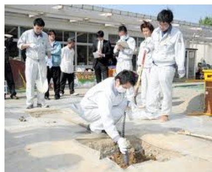
【写真】園庭に穴を掘り、線量を減らす上下置換工法の実地検証をする調査員＝8日午後3時30分ごろ、福島大付属幼稚園
